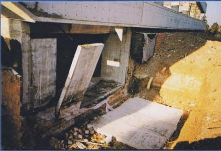
Beton duvarda KAPI-PENCERE, havalandırma kanalı boşluğu açılımı
